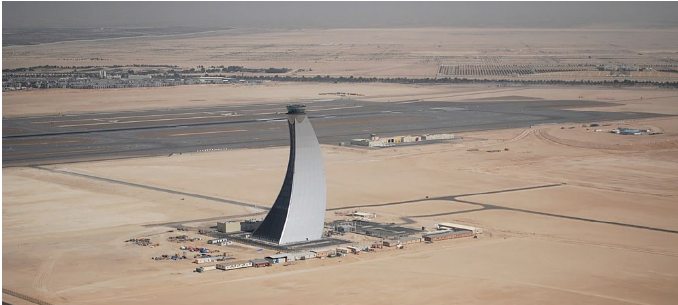
Новая диспетчерская башня аэропорта Абу-Даби
